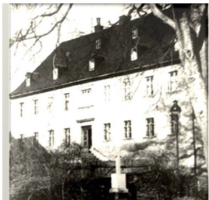
Foto: Das neue Schulgebäude neben der St. Niklas Kirche
