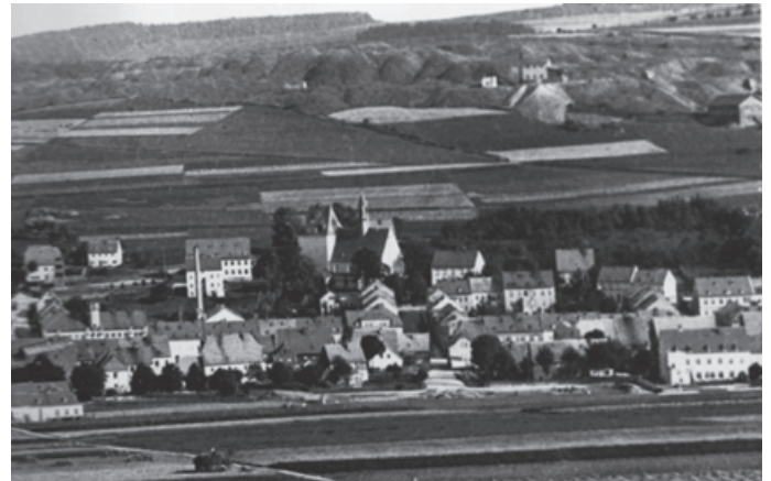
Baugelände (links im Bild Baugelände, rechts im Bild ehemalige Posamentenfabrik Hertel)
