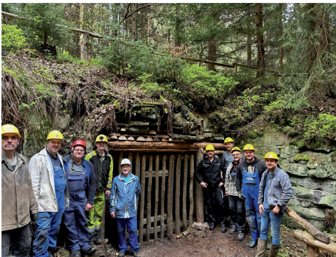
Vereinsmitglieder beim Erneuern der Rundhölzer an der Stülpnerhöhle
