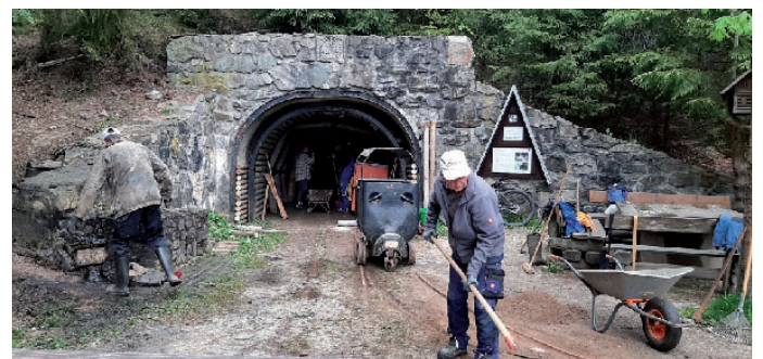
Bergbrüder beim Freilegen des Gleisbettes, links der kleine Brunnen, der nun wieder funktioniert
